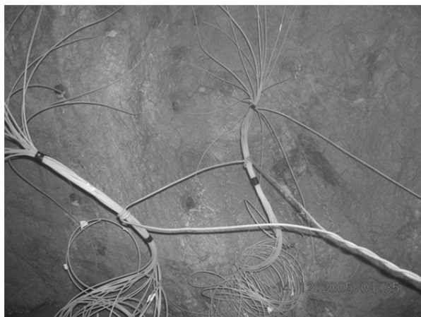
Рис. 9.14. Правильный монтаж взрывной цепи
